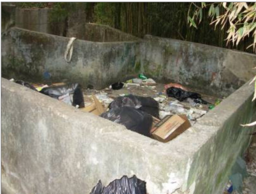
Foto 6. Área de acopio mostrada en la foto 5 (aledaña al edificio "ciclo básico 1"). Los desechos se acumulan al aire libre hasta su recolección
