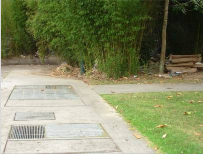
Foto 5. Área de acopio de desechos (arriba a la derecha) en la cual son transportados los desechos de la institución hasta su posterior recolección por parte de la empresa municipal de aseo urbano. A la izquierda se muestra las tanquillas de electricidad
